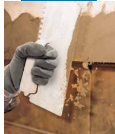
Восстановление фронтальной бетонной части балкона: финишная отделка
