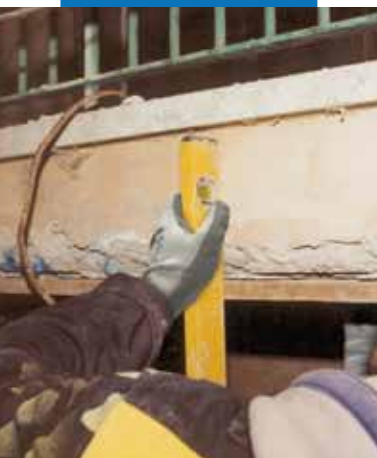
Восстановление фронтальной бетонной части балкона: обустройство деревянной опалубки
