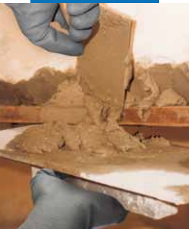
Восстановление фронтальной бетонной части балкона: нанесение Planitop 400
