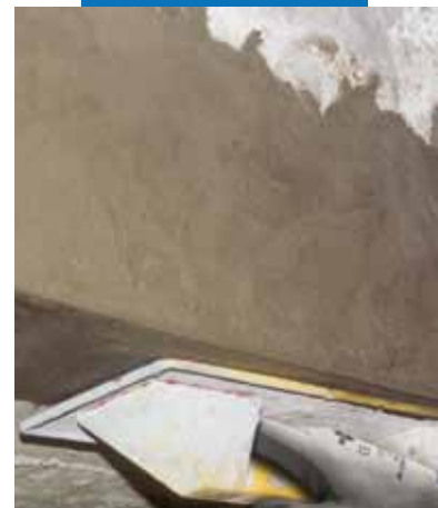
Ремонт бетонной балки
