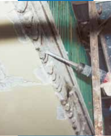
Восстановление фронтальной бетонной части балкона: подготовка основания
